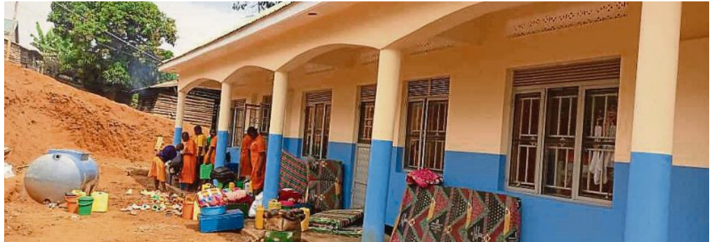
Mitte Februar zogen die Mädchen und jungen Frauen der Zoe-Mittelschule in ihr soeben fertiggestelltes neue Schlafsaalgebäude ein.
